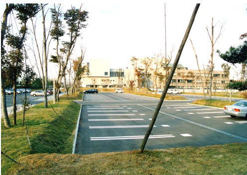
駐車場のエッジを盛り土し、緑化する。(名取市)
